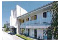
東館(個室9室×4ユニット)
